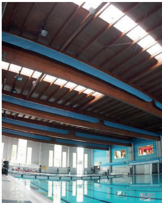
Piscine Sono stati realizzati lavori dell'impianto anti-incendio
